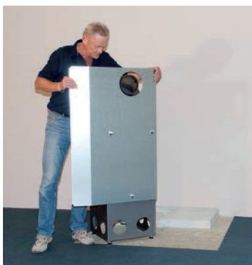
Namontovat protipožární ochranu (zvláštní příslušenství)
