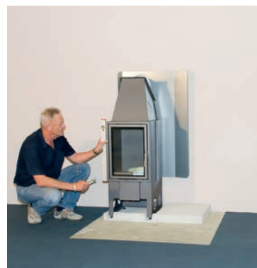
Ustavit krbovou vložku pomocí vodováhy
