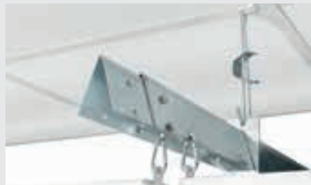
Zavěšení bafflu na V-profilu
