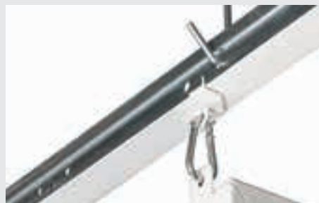
Zavěšení bafflu na V-profilu
