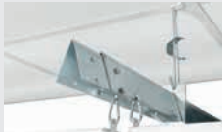
Zavěšení bafflu na V-profilu
