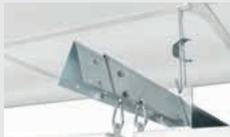
Zavěšení bafflu na V-profilu
